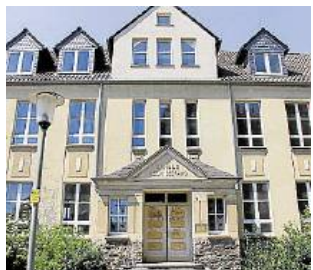
Soll abgerissen werden: die alte Lutherschule.
